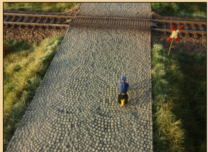
Das Ergebnis fotografiert in Abendstimmung. Durch das Streiflicht der tief stehenden Sonne bilden sich reizvolle Kontraste. Die Plattenstöße sind kaum noch wahrzunehmen.
