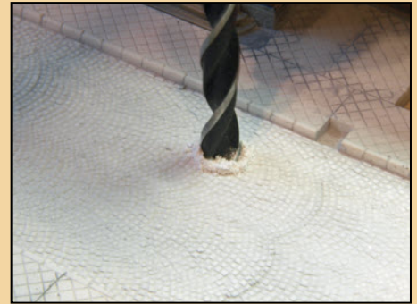
Für den Einbau werden einfach mit hoher Drehzahl und wenig Druck Löcher mit \varnothing 10\text{mm} in das Pflaster gebohrt
