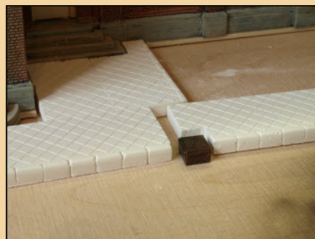
Für den Einbau wird ein Ausschnitt in den Bürgersteig gesägt.
