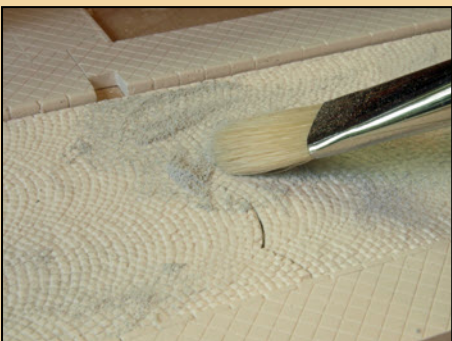
Kleine Spalte in den Stoßfugen sind kein Problem und werden später sowieso ausgefügt. Dazu wird ein Borstpinsel in das Spezialgipspulver getaucht und der Gips dann in die Fuge eingefegt.
