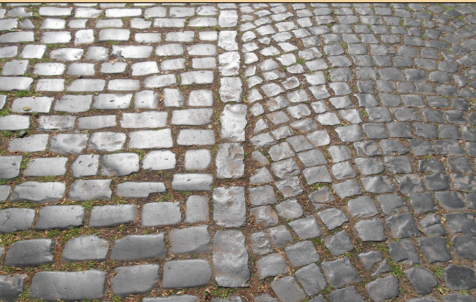
Großformatiges Reihenpflaster (links) und Segmentbogenpflaster (rechts) im Bereich der ehemaligen Schüttguttrutsche in Hann. Münden „vor der Bahn“. Im Bereich des Mündener Bahnhofs wurde das Segmentbogenpflaster für die Zuwegungen verlegt, in den Ladebereichen das Reihenpflaster.
